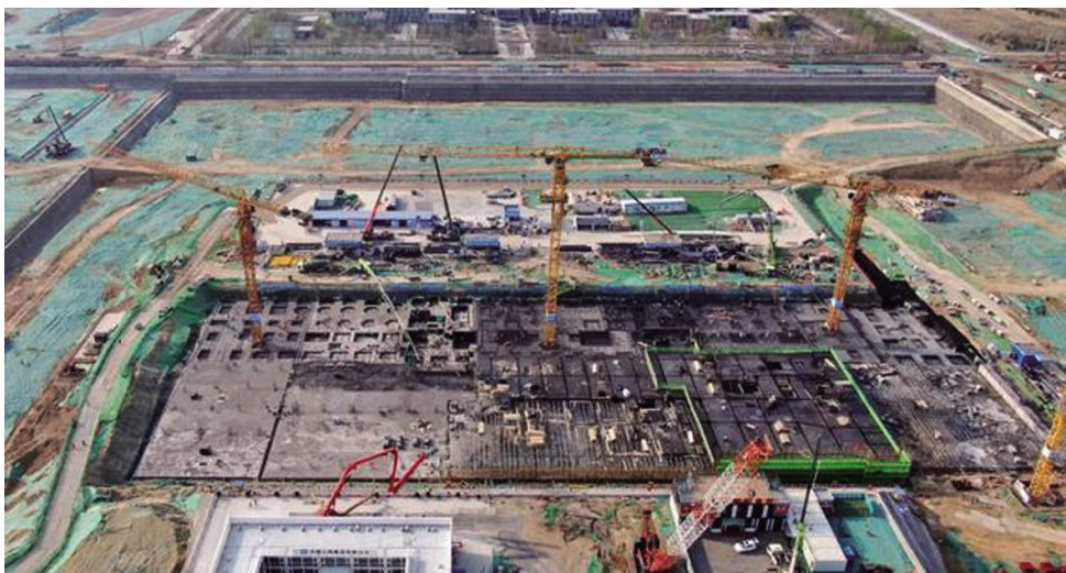
雄安项目施工现场
